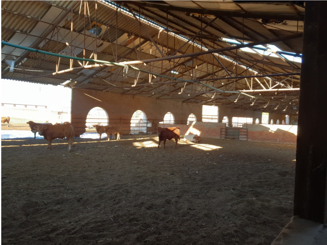
INTERIOR ESTABLOS 1 Y 2
