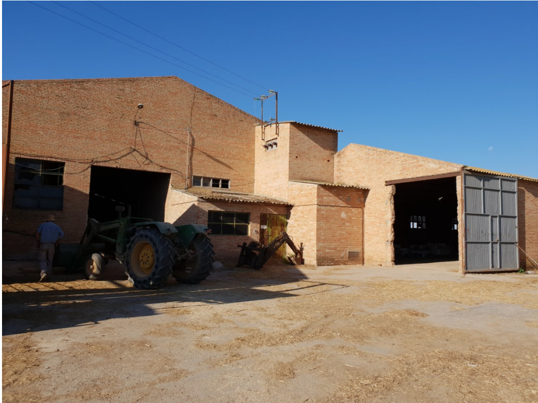
VISTA EXTERIOR ALMACEN 2
