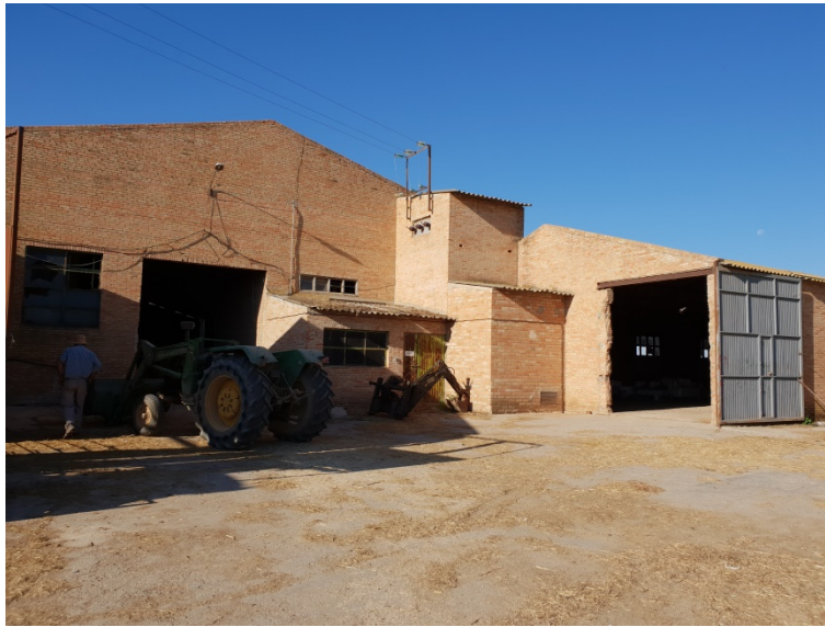
VISTA EXTERIOR ALMACÉN 2
