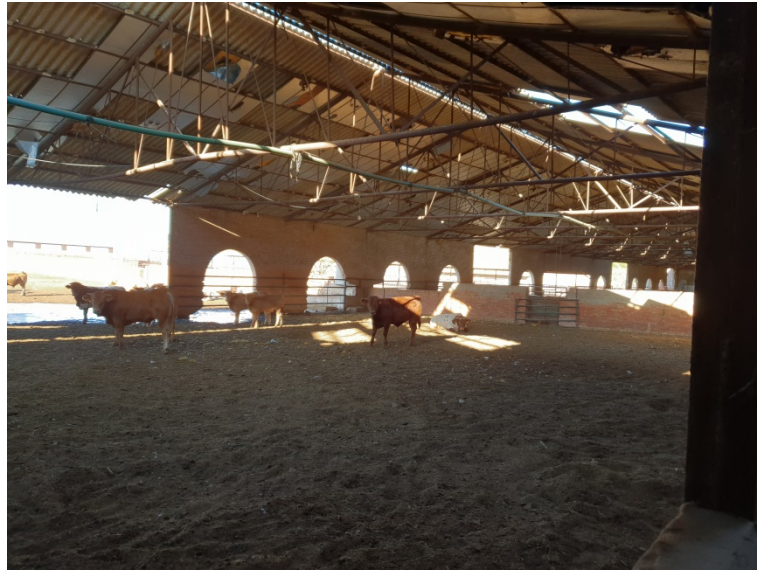
INTERIOR ESTABLOS 1 Y 2
