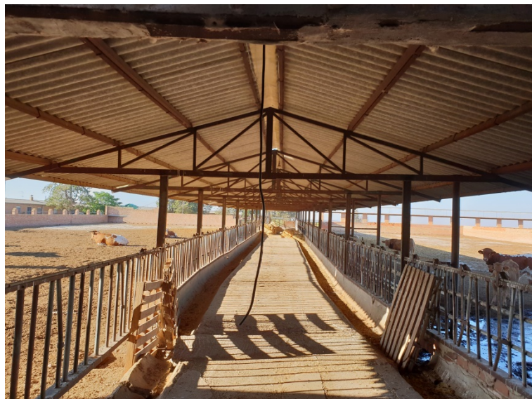
VISTA PATIOS EXTERIORES. PASILLO CON COMEDEROS
