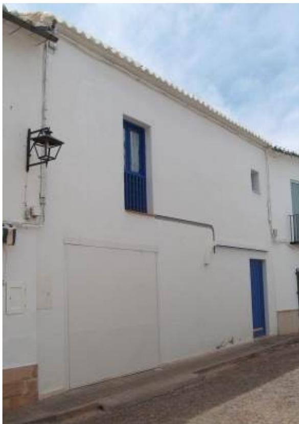
1.1. Puerta basculante, metálica (mimetizada con fachada).
