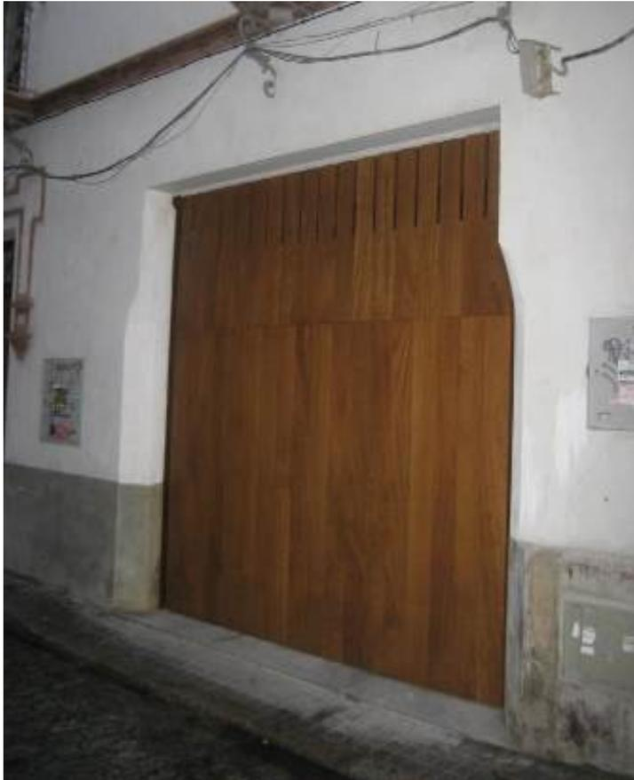
1.3. Puerta basculante, lamas de madera verticales y bastidor metálico no visto.
