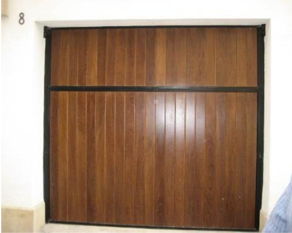
1.2. Puerta basculante, lamas de madera verticales y bastidor metálicovisto.
