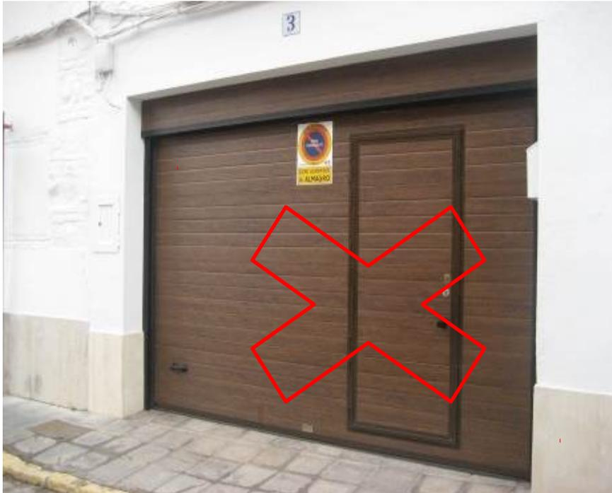
2.2. Puerta seccional, lama horizontal acabada en PVC imitación madera (lama horizontal estrecha).
