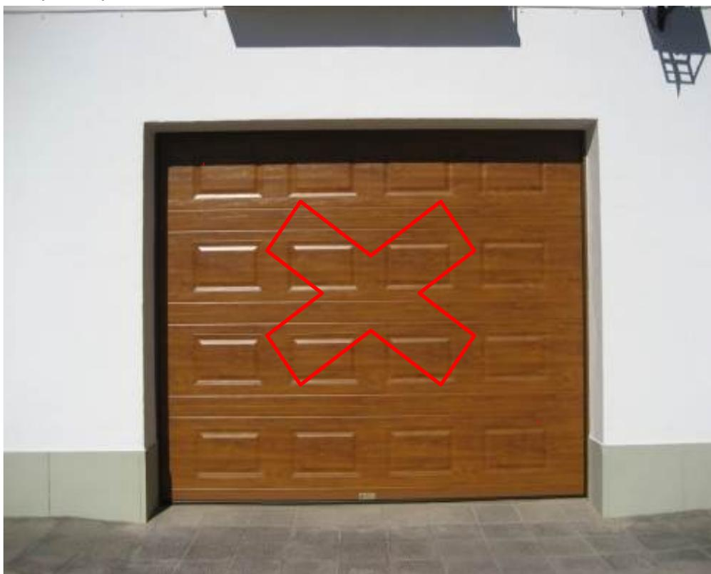
2.1. Puerta seccional, lama horizontal acabada en PVC imitación madera (cuarterones).
