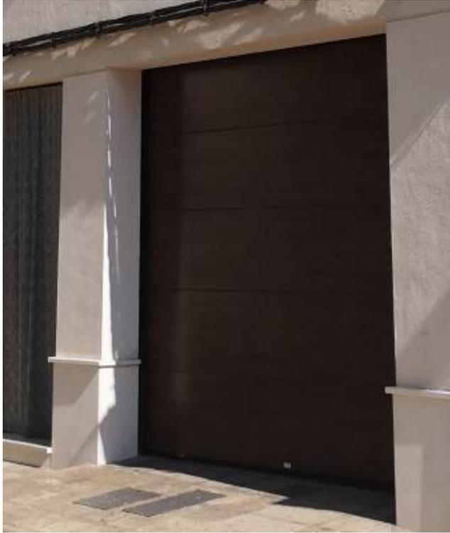
1.6 Puerta seccional, lamas metálicas horizontales.
