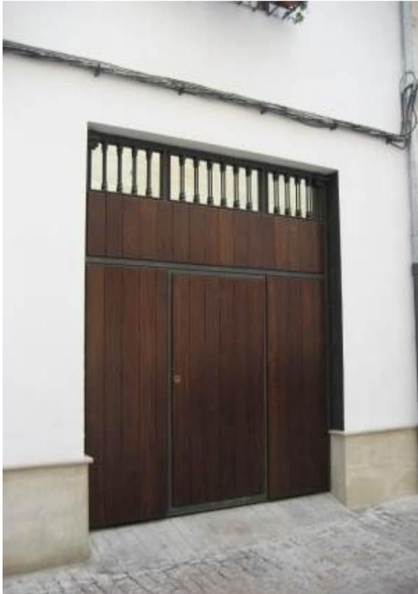
1.4. Puerta basculante, lamas de madera verticales y bastidor metálico visto (con iluminación). Autorizable únicamente en Zona 5 de Respeto del Conjunto Histórico.
