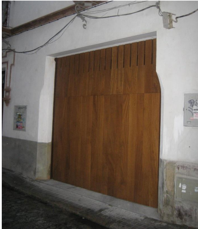
1.3. Puerta basculante, lamas de madera verticales y bastidor metálico no visto.
