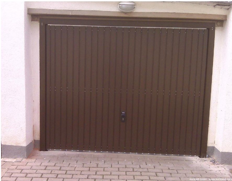
1.5. Puerta basculante, lamas metálicas verticales.
