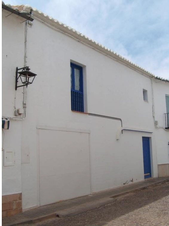
1.1. Puerta basculante, metálica (mimetizada con fachada)
