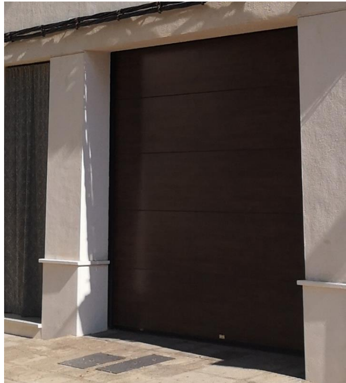
1.6 Puerta seccional, lamas metálicas horizontales.
