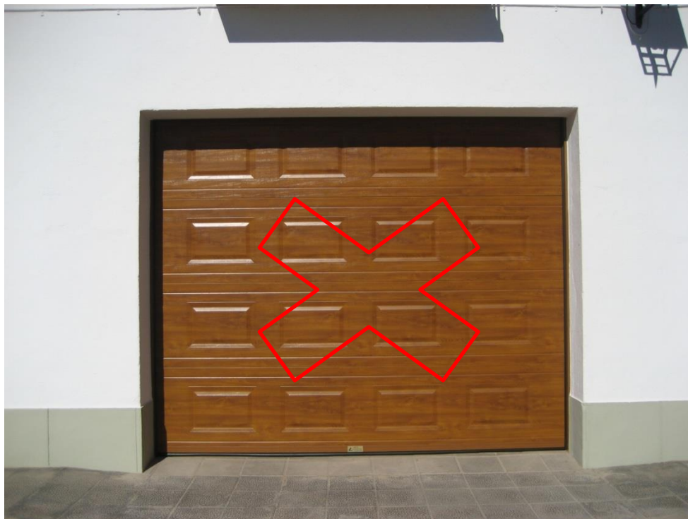
2.1. Puerta seccional, lama horizontal acabada en PVC imitación madera (cuarterones).
