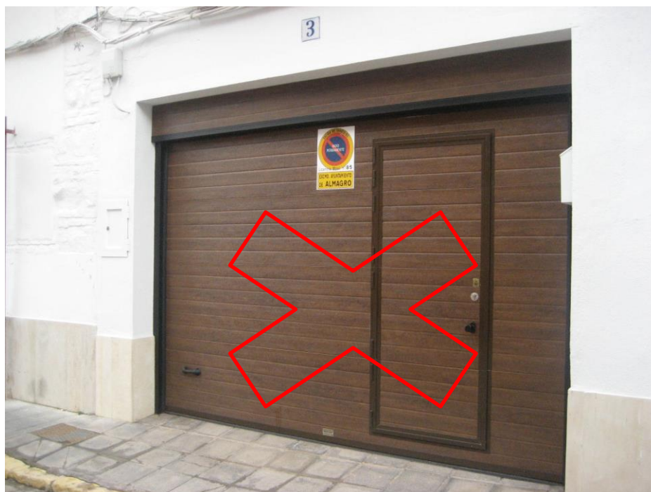
2.2. Puerta seccional, lama horizontal acabada en PVC imitación madera (lama horizontal estrecha).
